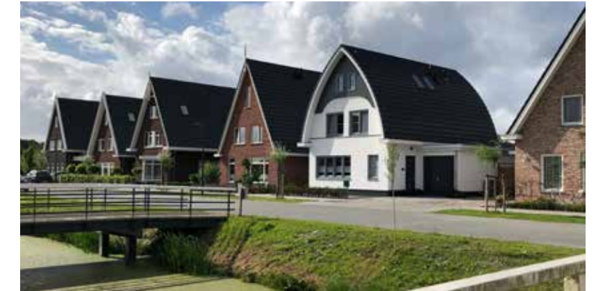
Op de aangegeven kavels zijn witte gevels toegestaan
